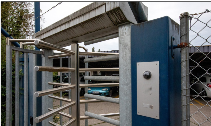
Auch zum Personenzugang besteht eine Audio- und Videoverbindung
